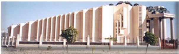
شكل رقم ٢٤ - الغلاف الخارجى للمبنى حيث تم تصميمه لتقليل الحمل الحرارى
