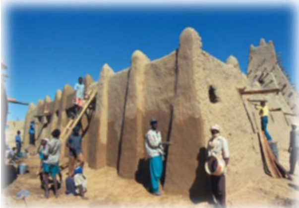
شكل رقم ٣ - حماية وإنقاذ المساجد القديمة في تمبكتو - مالي من أخطار التآكل بسبب العواصف الرملية وزحف الكثبان الرملية من خلال إزالة الرمال وتجديد طبقات البياض الخارجية للتقوية والتدعيم. المصدر: كونييت، أوجستين، ٢٠١٣ م، "دراسات حالات عن تغير المناخ والتراث العالمي"، النسخة المترجمة، النيونكو .
