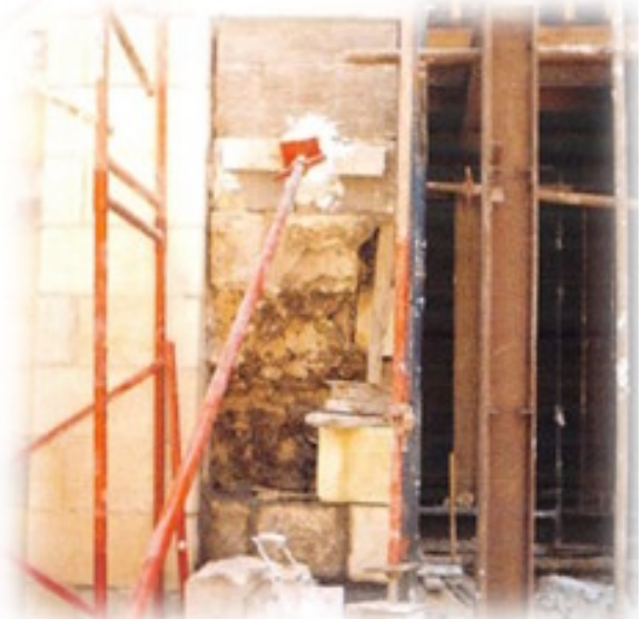
شكل رقم ١ - أعمال التدعيم والتقوية لقصر الأمير طاز بعد تضرره من زلزال عام ١٩٩٢م. المصدر: قصر الأمير طاز، مشروع القاهرة التاريخية، المجلس الأعلى للآثار، وزارة الثقافة.
