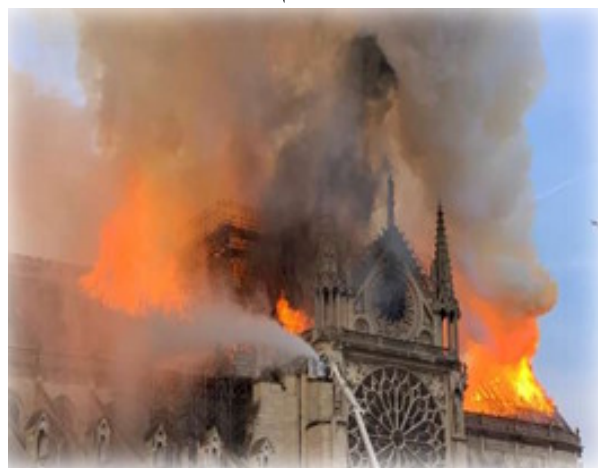
شكل رقم ٤ - الجهود المبذولة لإخماد الحريق الهائل بكنيسة نوتردام - فرنسا.
