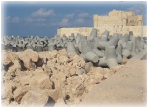
شكل رقم ٧ - إقامة حواجز غاطسة داخل مياه البحر لحماية قلعة قايتباي بالاسكندرية من مخاطر التغير المناخي وارتفاع منسوب سطح البحر ، صور أضخم مشروع لحماية قلعة قايتباي بالاسكندرية من التآكل، أسامة/٢٩٩٤٦١٠
