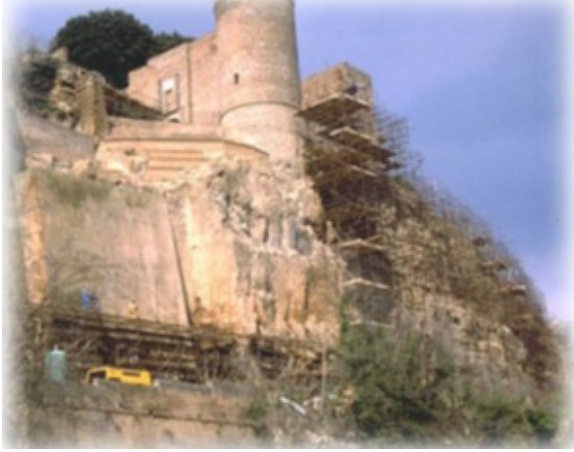
شكل رقم ٢ - حجم الأعمال الكبيرة المنفذة لتدعيم وتثبيت جوانب الصخرة لحماية المباني التراثية من الانزلاقات الأرضية الناتجة من السيول - مدينة أورفيتو - إيطاليا. المصدر: فهد، إيزيس محي الدين عبده، ٢٠١٠م، "تجربة الترميم والحفاظ على التراث في إيطاليا - أورفيتو حالة دراسية، وإمكانية تطبيقها في فلسطين - عراق بورين حالة دراسية"، ماجستير، جامعة النجاح الوطنية، كلية الدراسات العليا، نابلس، فلسطين.
