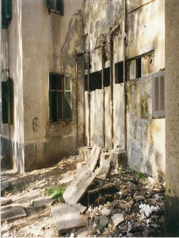
شكل رقم ٣- تسرب المياه من مواسير الصرف الصحي وحدوث نشع للمياه وتمليح
