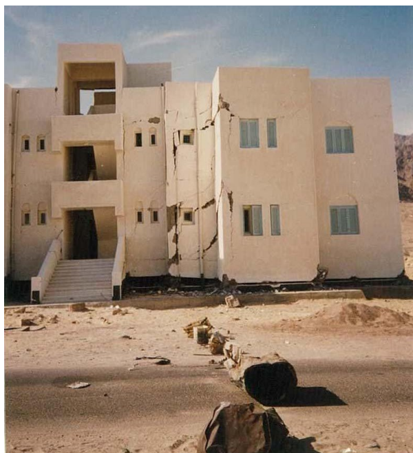
شكل رقم ٥- شروخ مائلة بالواجهة الرئيسية نتيجة لفروق الهبوط بين الأساسات
