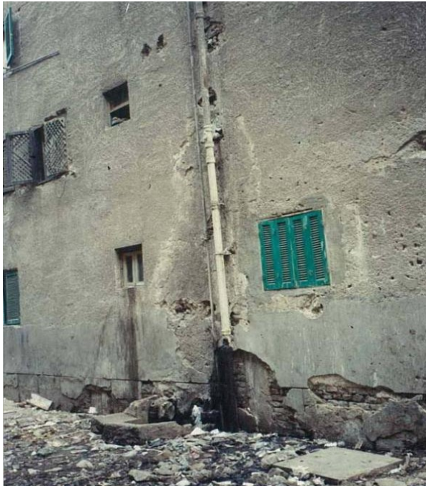
شكل رقم ٤- كسر في احد مواسير الصرف الصحي بعمارة سكنية مما تسبب في تاكل البياض واتصدع العناصر الانشائية
