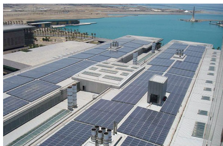
شكل رقم ١١- يوضح استخدام خلايا الطاقة الشمسية على أسطح أحد مباني جامعة الملك عبدالله للعلوم والتقنية بالسعودية (KAUST Solar Park) ٢٥
