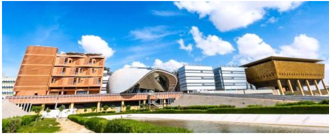
شكل رقم ٥،٤- يوضح دمج التشكيل المعماري للواجهات مع نظم التظليل الذكي والتقنيات النظيفة لتوفير استهلاك الطاقة في مدينة مصدر بأبوظبي (المصدر: مدينة مصدر، www.masdar.ae ) ١٥
