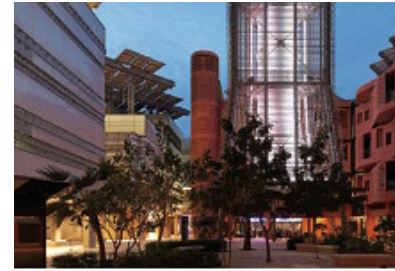
شكل رقم ٥،٤- يوضح دمج التشكيل المعماري للواجهات مع نظم التظليل الذكي والتقنيات النظيفة لتوفير استهلاك الطاقة في مدينة مصدر بأبوظبي (المصدر: مدينة مصدر، www.masdar.ae ) ١٥
