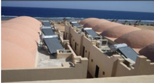
شكل رقم ٨،٧- يوضح استخدام نظم التسخين الشمسي للمياه علي أسطح مباني الجامعة الأمريكية بالقاهرة الجديدة، وأسطح أحد فنادق مدينة الغردقة ١٧
